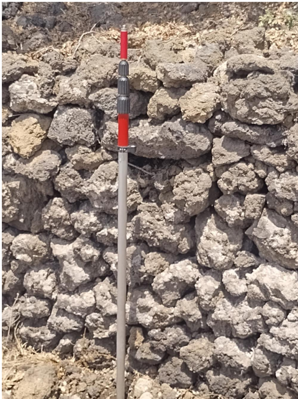
Tratto di Muro n° 5 con H. 1.40
