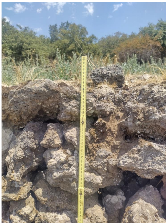
Foto tratto Muro n° 1 con H. di ml 2.00
