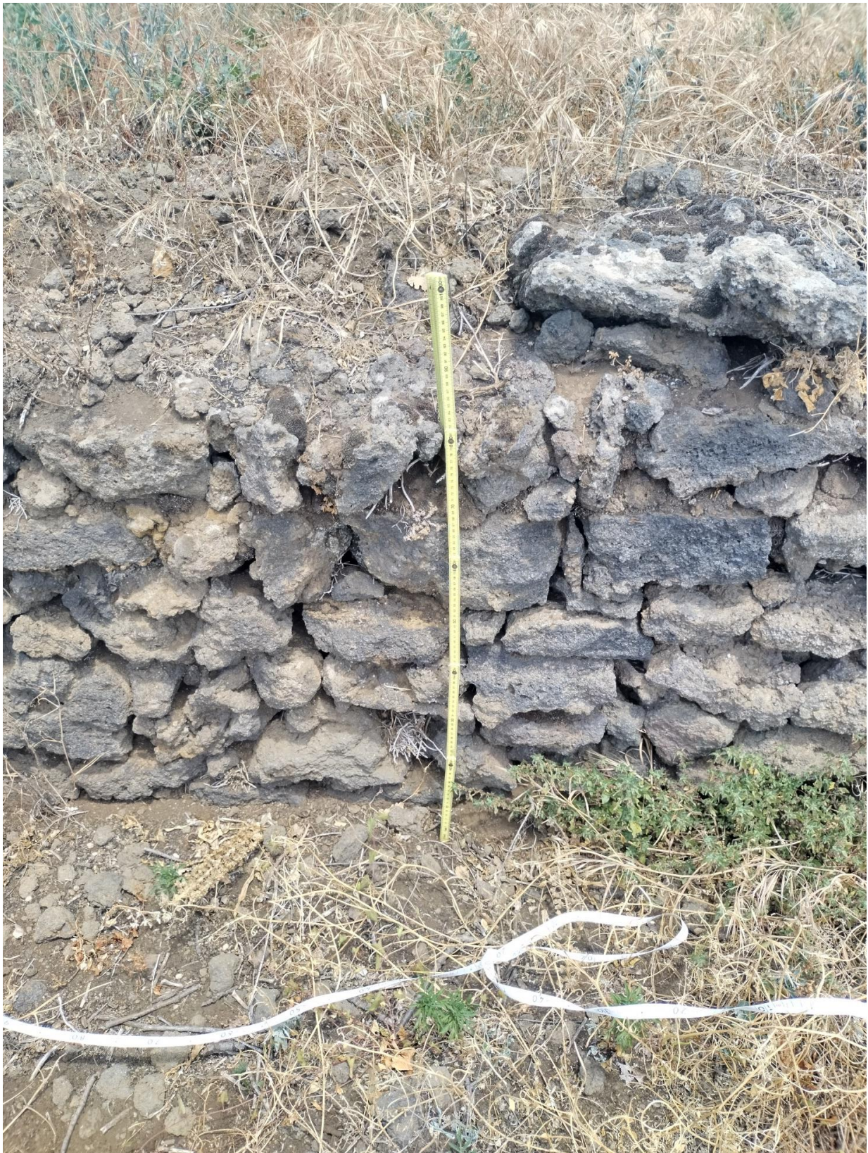
Tratto di Muro n° 4 con H. 1.00
