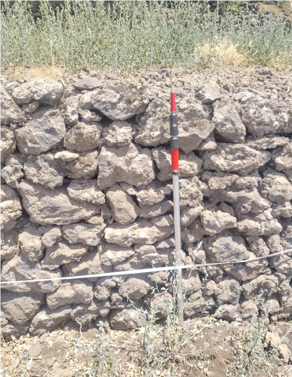
Tratto di Muro n° 2 con H. 1.50
