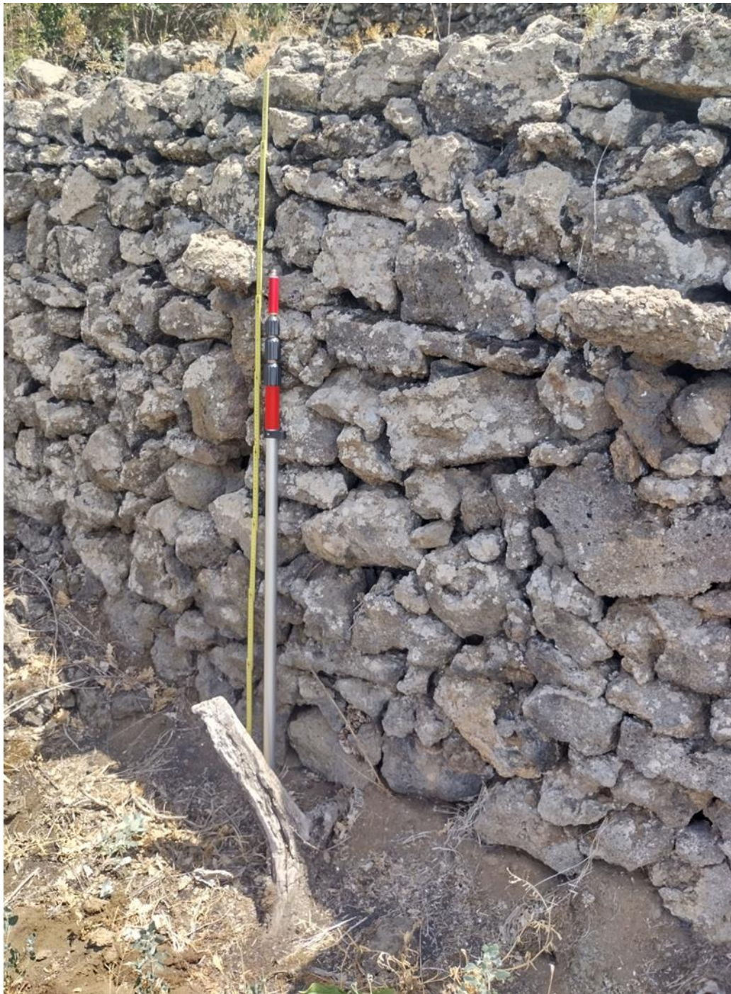
Tratto di Muro n° 2 con H. 2.00
