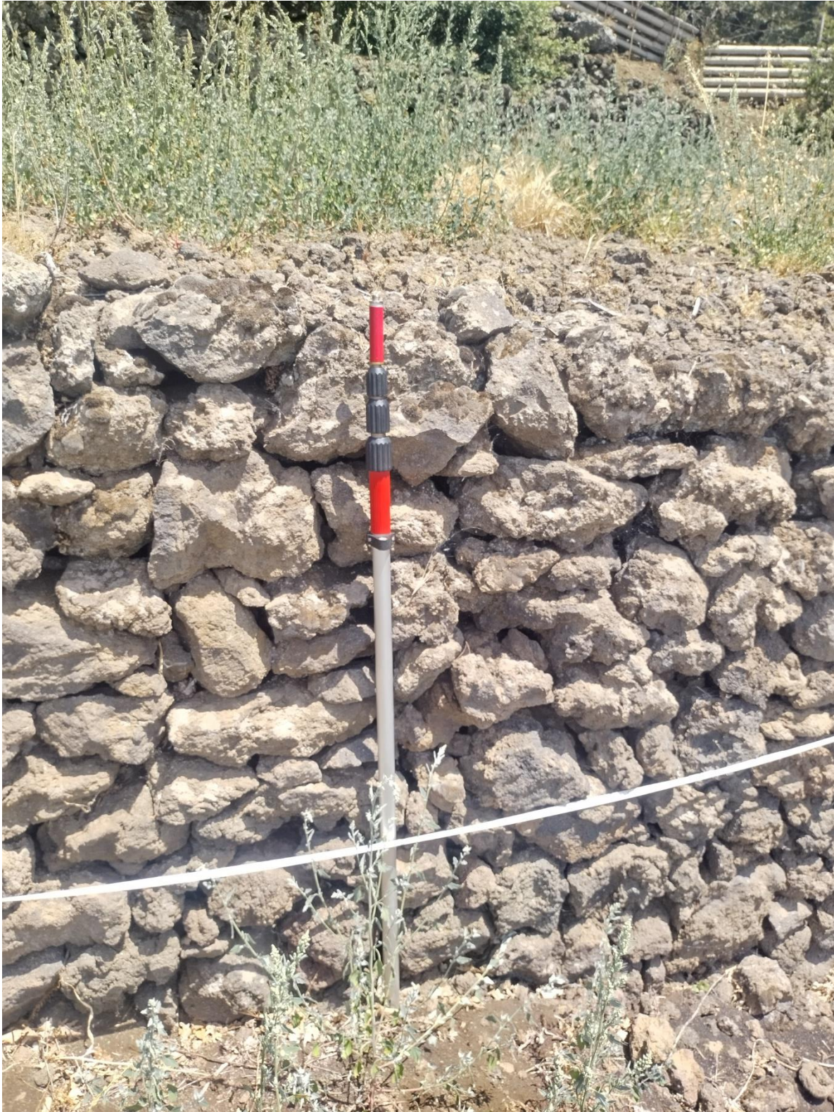
Tratto di Muro n° 2 con H. 1.50
