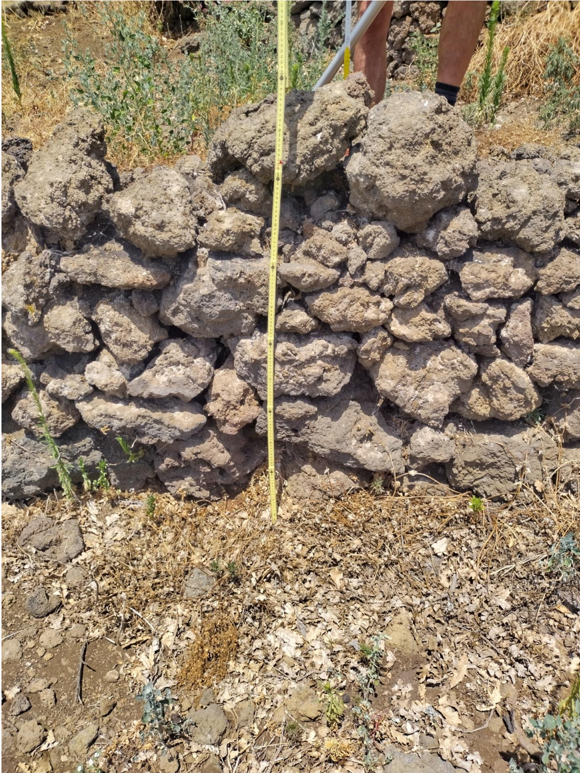
Tratto di Muro n° 6 con H. 1.20
