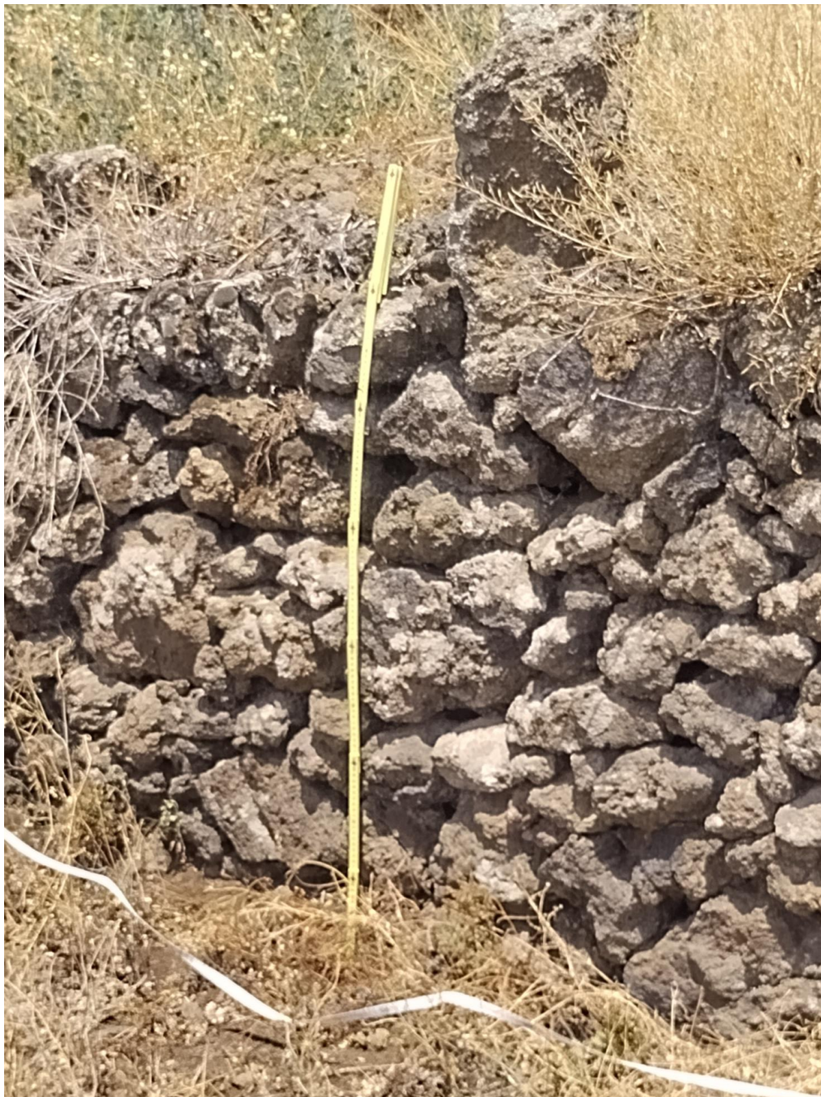
Tratto di Muro n° 3 con H. 1.40
