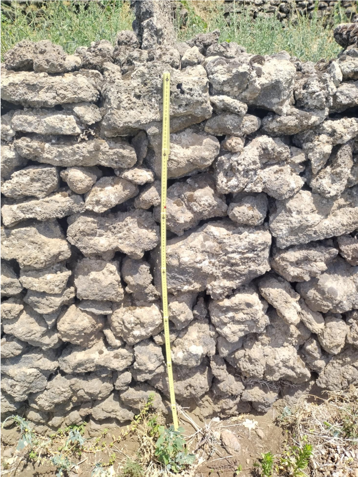
Tratto di Muro n° 4 con H. 1.30
