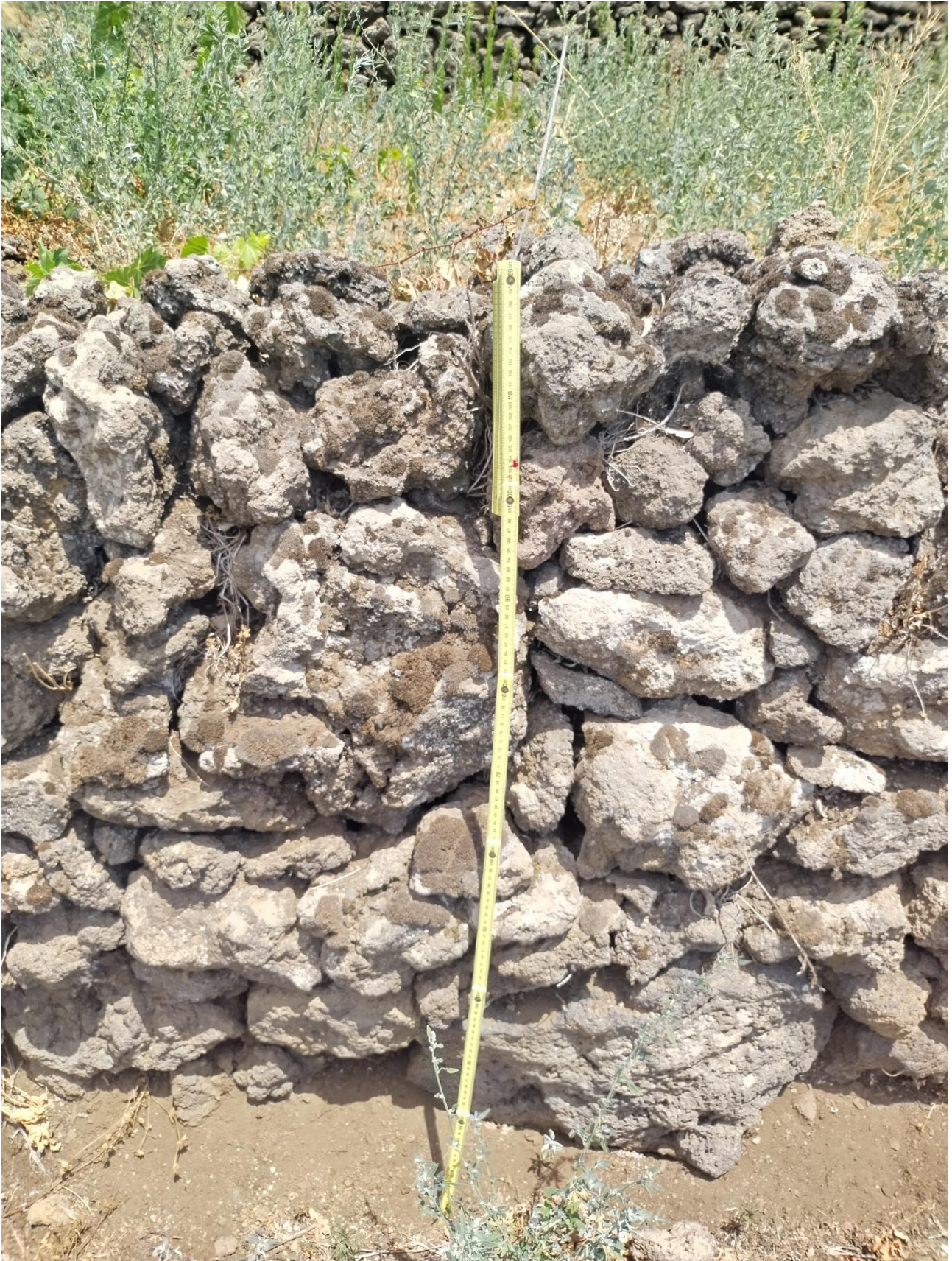
Tratto di Muro n° 6 con H. 1.20
